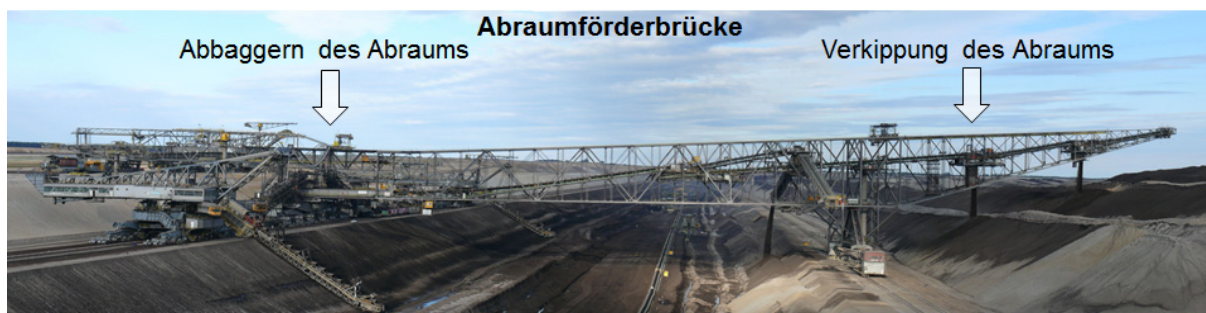
Abbildung 7: Abraumförderbrücke (F60) in einem Tagebau der Lausitz – Quelle des Fotos: [U 13]
