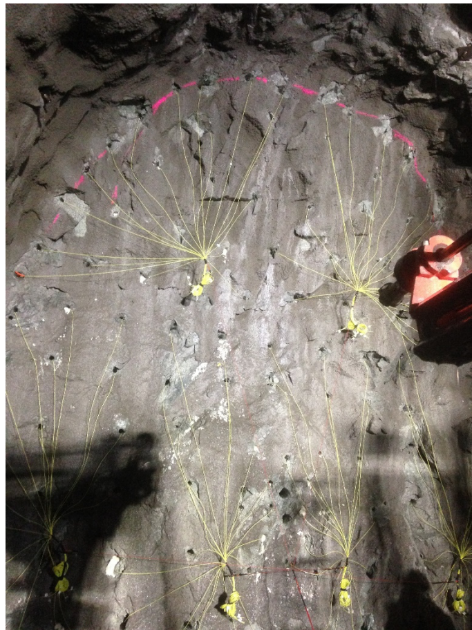
Abbildung 12: Nichtelektrisches Zündsystem mit vier Sektoren; Quelle: SSE
