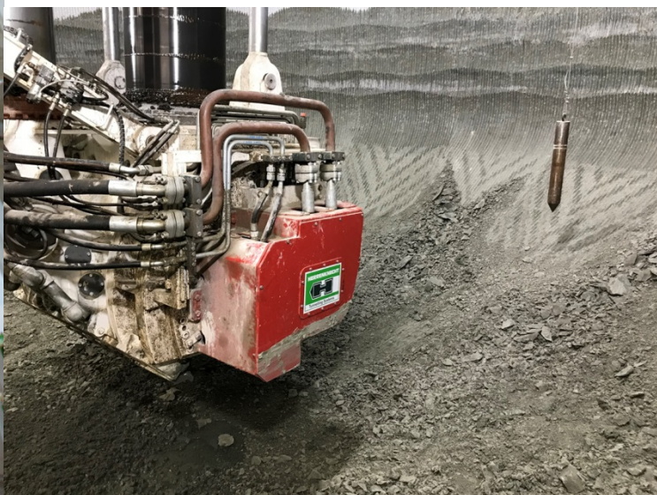
Abbildung 3: Der Schneidausleger im Vortrieb
