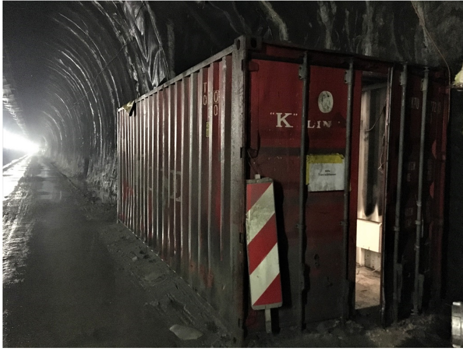
Abbildung 7: Lagercontainer für die Emulsion; Quelle: ARGE NAT II
