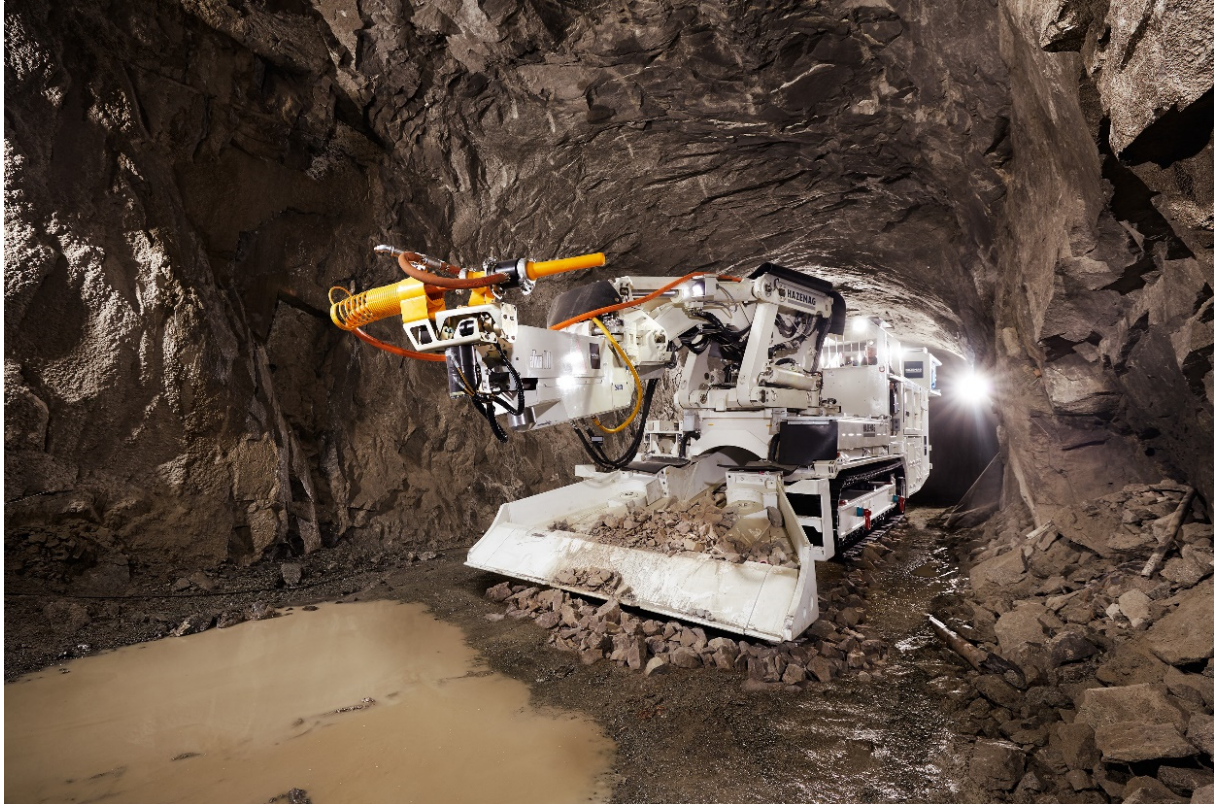
Abbildung 5: HRE mit Spritzbeton-Manipulator
