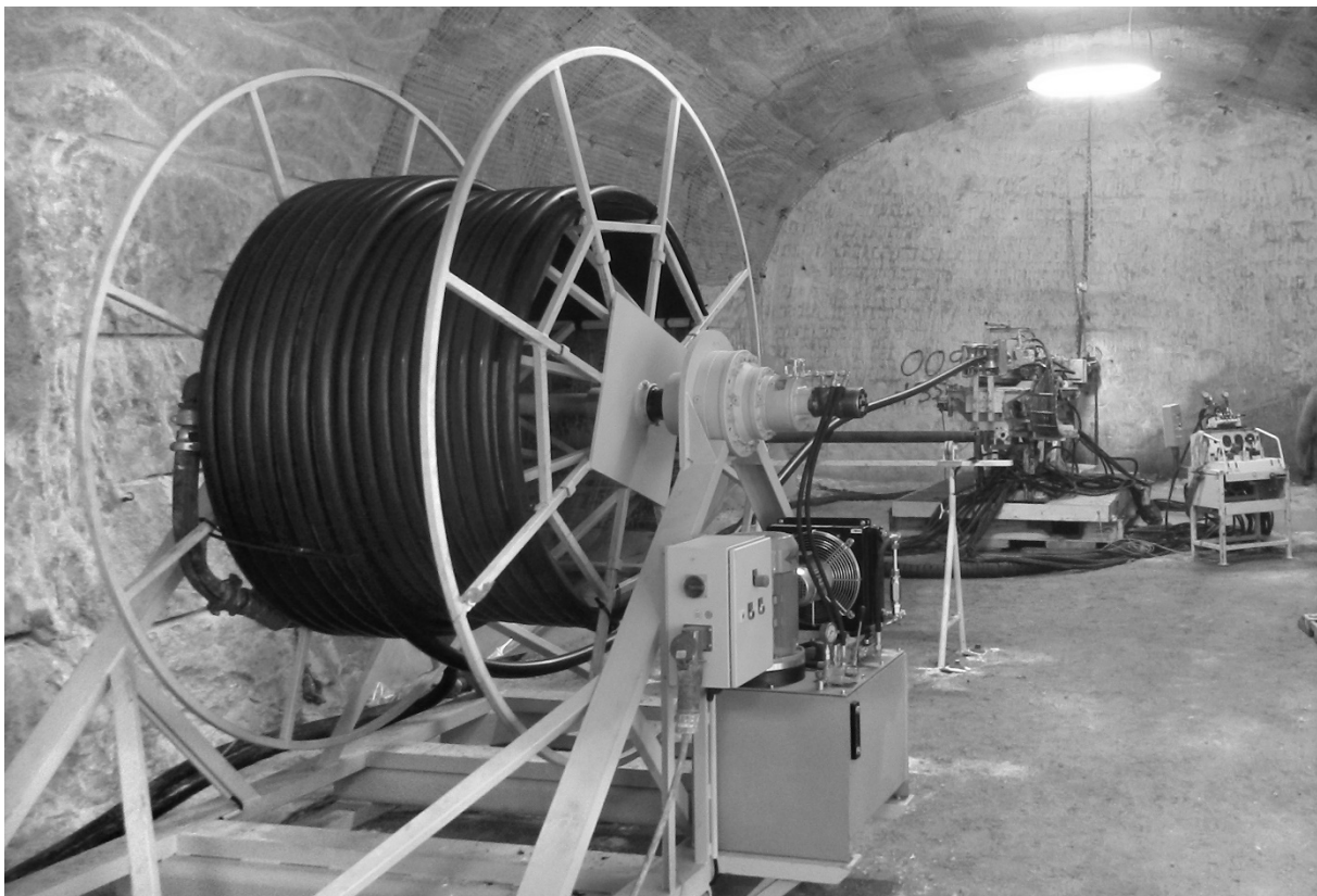
Abbildung 6: Verfüllung der Bohrung RB132. Schlauchwickleinheit und zur Bohrmaschine Diamec 282 reichende PE-Leitung
