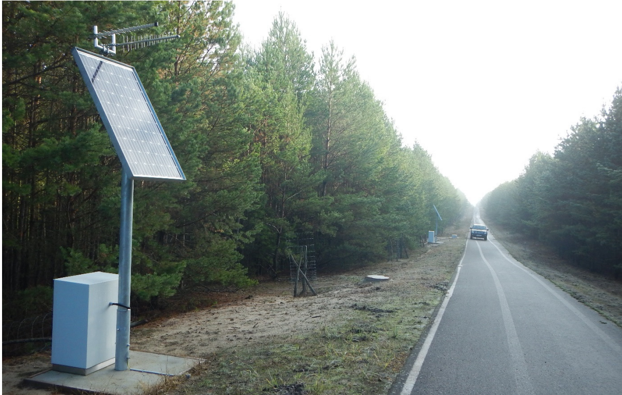
Abbildung 5: Kippenstraße (Radweg) in einem gesperrten Kippengebiet vor Eintritt eines Verflüssigungsereignisses
