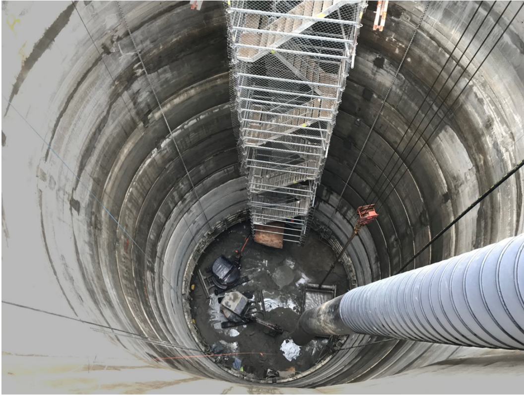
Abbildung 6: Fertiggestellter Vorschacht
