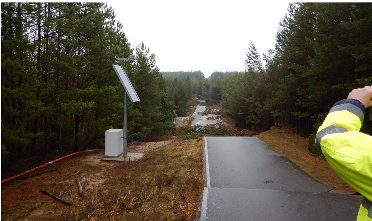
Abbildung 6: Kippenstraße nach Eintritt eines Verflüssigungsereignisses (gleicher Fotostandort wie bei Abbildung 5)
