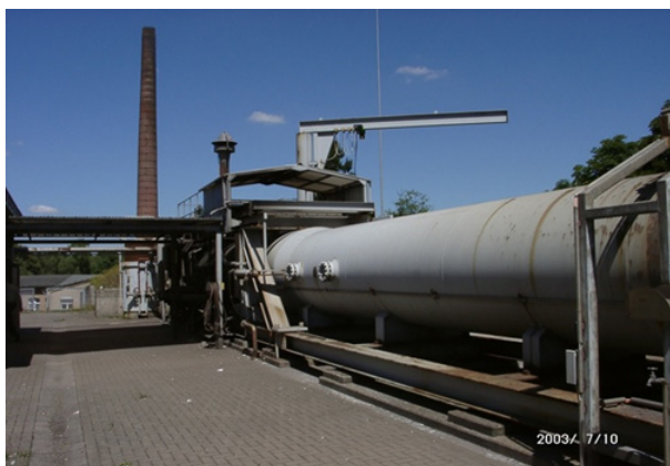
Abbildung 9: Sprengstoffprüfstrecke der MAXAM in Haltern/Sythen Quelle: MAXAM GmbH
