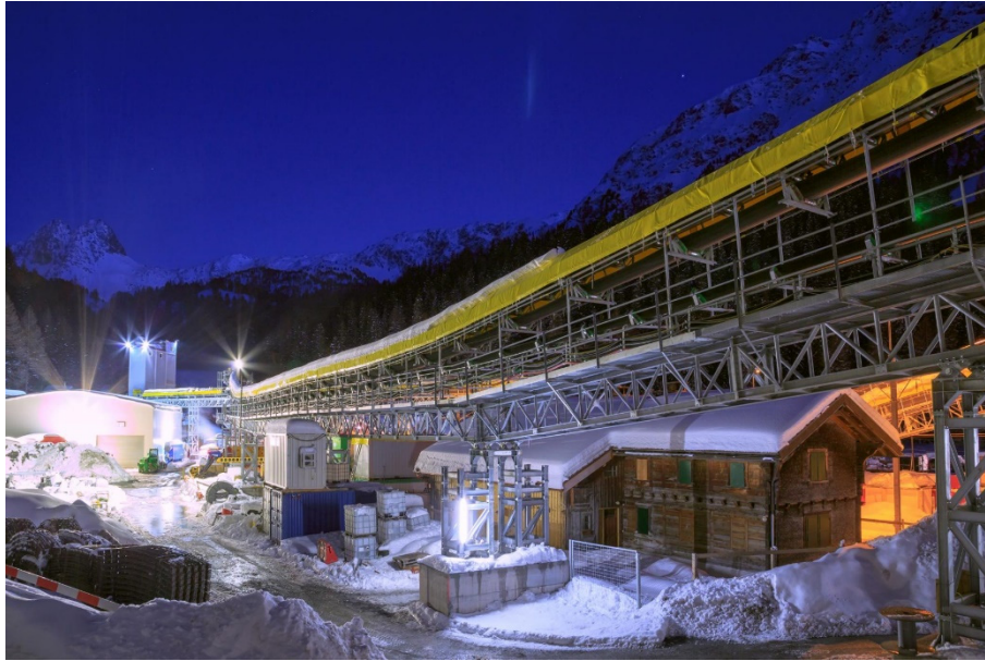
Abbildung 3: Installationsplatz Nord mit ehemaligem Wärterhaus, Quelle: ARGE NAT II
