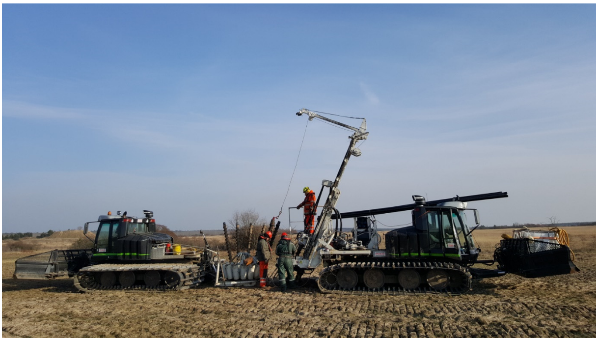
Abbildung 14: Leichte und leistungsfähige Bohrtechnik beim Abteufen eines Sprengbohrloches für die SSPV
