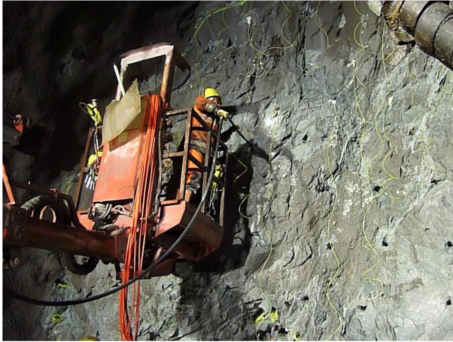
Abbildung 9: Ladearbeiten im Vortrieb Preda; Quelle: SSE
