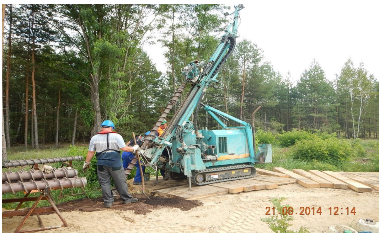
Abbildung 13: Konventionelle Bohrtechnik beim Abteufen eines Sprengbohrloches für die SSPV
