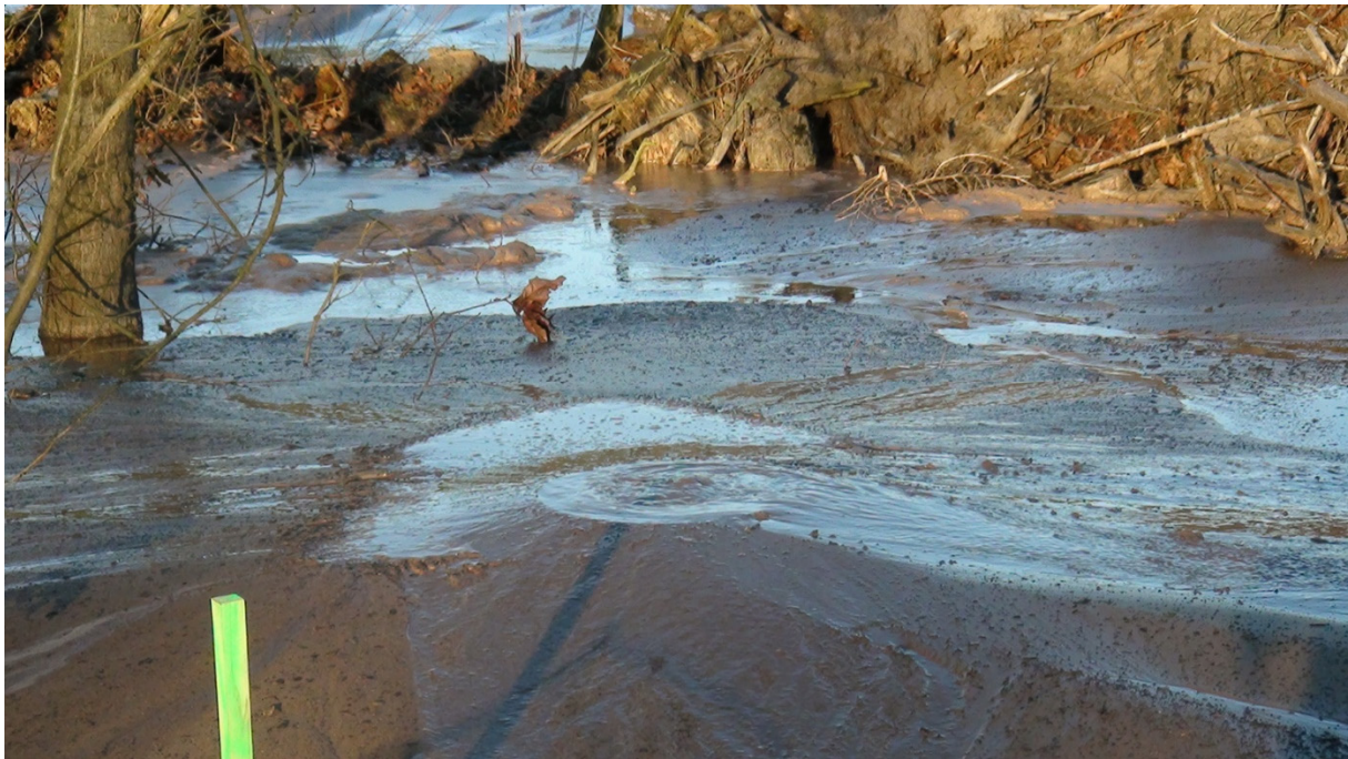
Abbildung 12: Sandvulkan (Austrittsstelle des bei der SSPV ausgepressten Porenwassers) im Bereich eines (vorher) hergestellten Perforationsbohrloches
