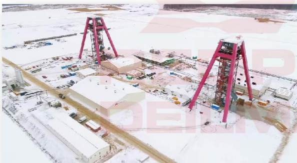
Октябрь 2019 320м стволы пройдены/тубинги смонтированы/ гидроизоляция
