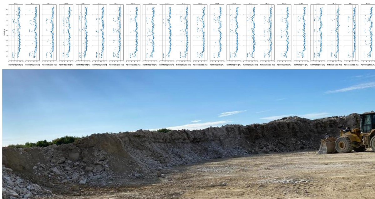
Abbildung 4: Zweidimensionales Qualitätsprofil der Lagerstätte basierend auf den Ergebnissen der Online Analyse des Bohrmehls von 22 Sprengbohrungen
