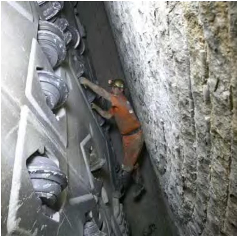
Abbildung 7: Kontrolle und Wechsel der Rollenmeißel (Robbins)
