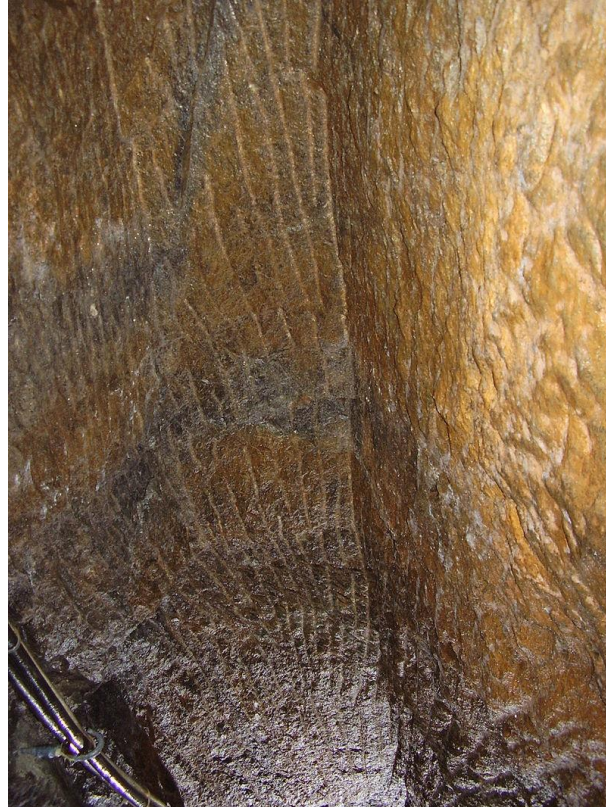
Abbildung 2: Frässpuren in einem sehr alten Grubenbau (Von Markscheider, CC BY-SA 3.0 de)
