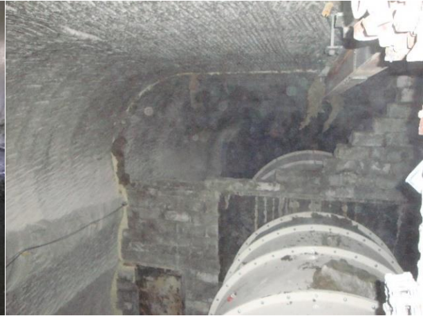
Abbildung 4: eingestürzte Wetterwand
