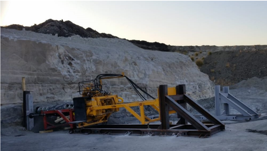
Abbildung 1: Probebohrungen mit einer Pressbohranlage des Typs PBA155 in Südafrika
