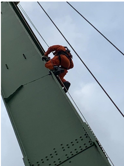
Abbildung 2: Abseilbegehung beider Schrägstreben
