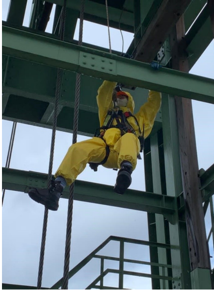
Abbildung 4: Abseilbegehung an der Führungsgerüst Mittelwand
