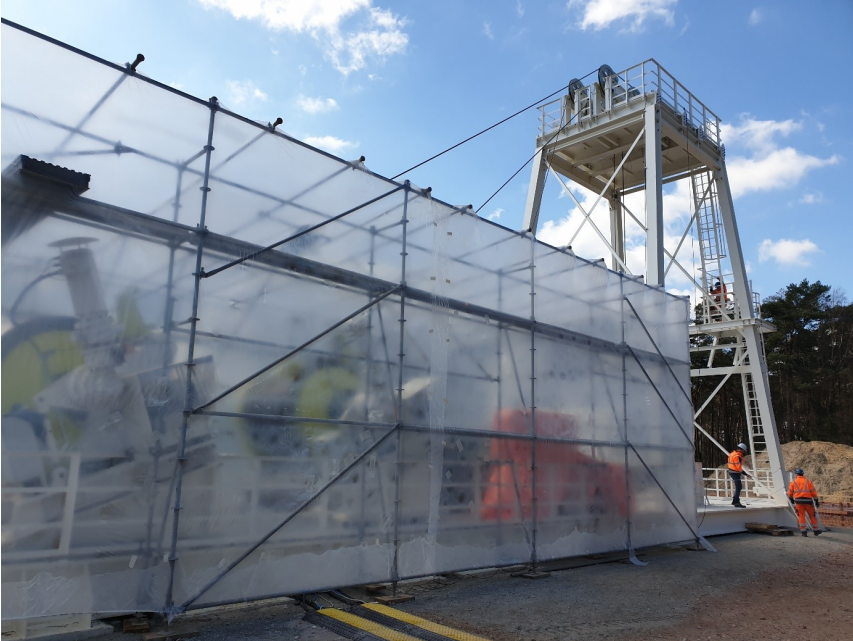
Abbildung 2: temporäres Fördergerüst
